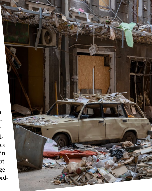
Am 2. März trafen russische Raketen das historische Zentrum von Charkiw: der „Palast der Arbeit“ – (1914, Neoklassizismus) für Banken und Geschäfte – am „Platz der Verfassung“ wurde in Teilen zerstört.
